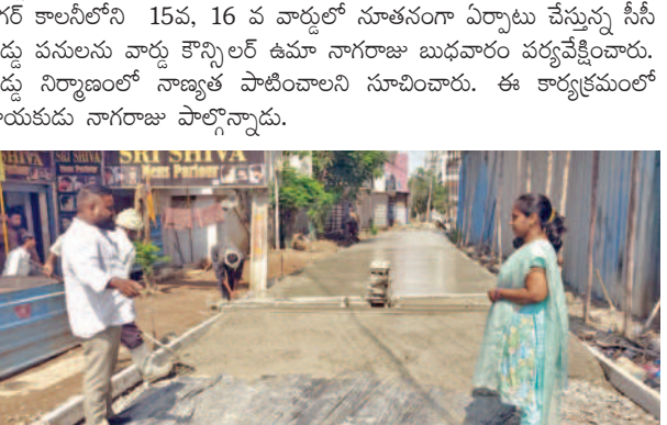
మేధుల్‌లోని రాఘవేంద్రనగర్‌లో సీస రోడ్డు నిర్మాణ పనులను పరిశీలిస్తున్న మున్సిపల్ కౌన్సిలర్ ఉమా నాగరాజు
